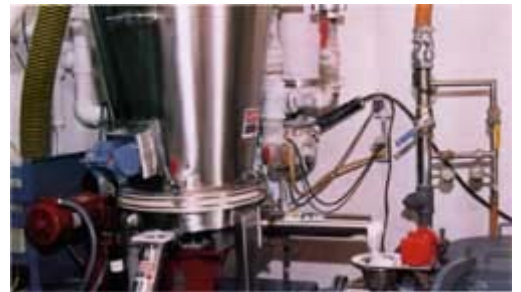
En Jet Pulverizer, el dosificador es usado para dosificar material hacia los molinos inyectoros.
